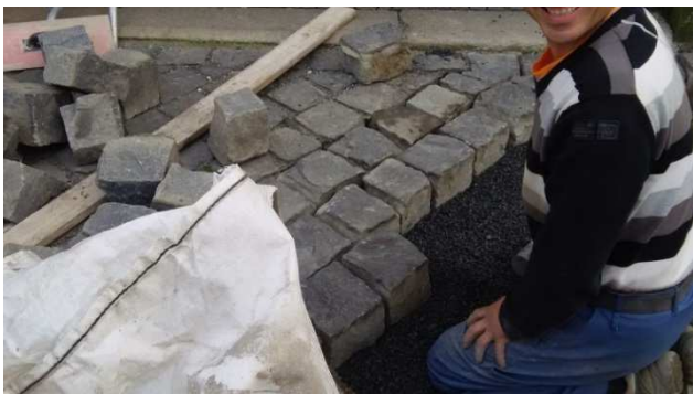
〔石畳の施工中〕
