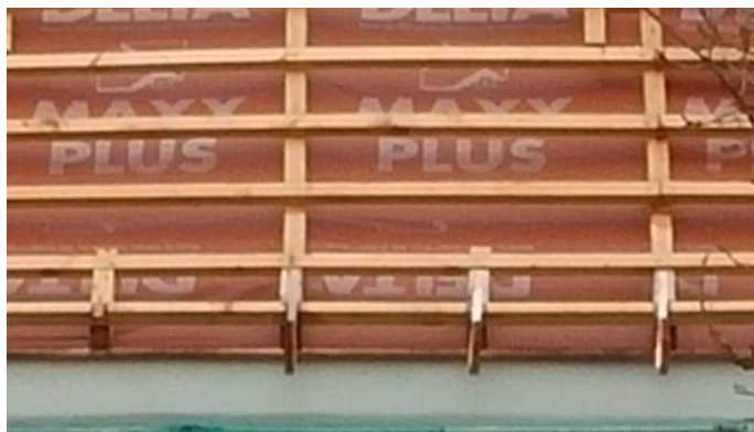
〔屋根の通気が分かる拡大写真〕
